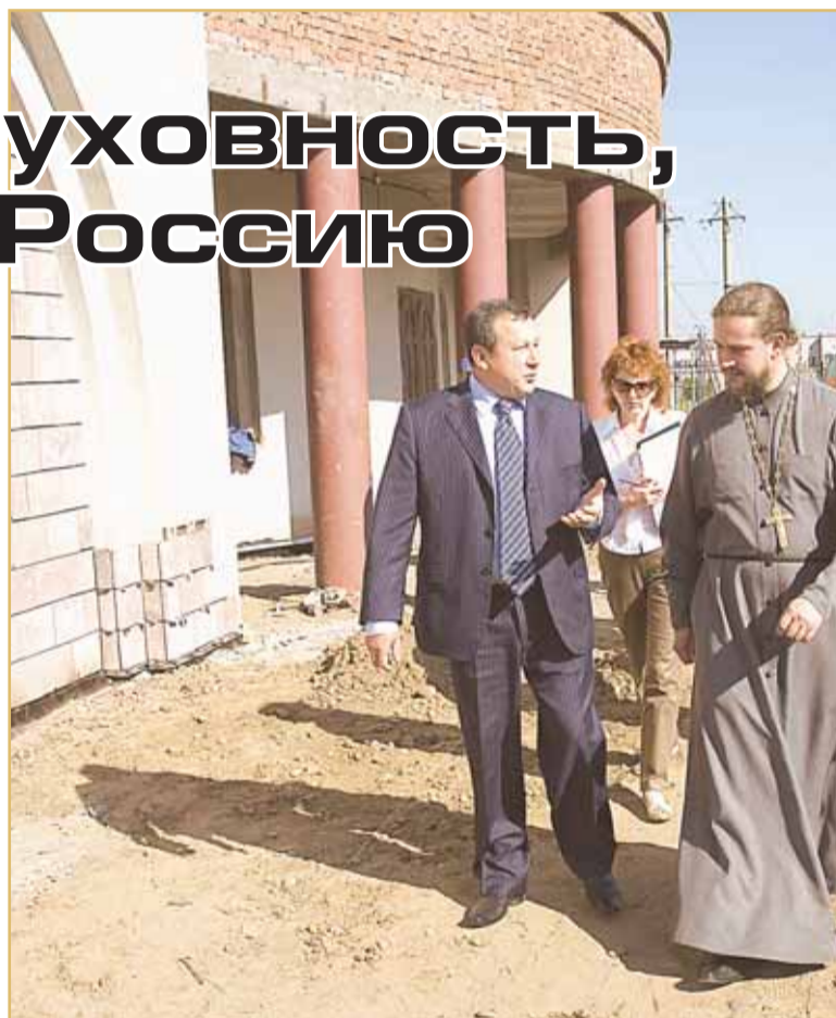
Г. Г. Гилаев и отец Максим обсуждают ход строительства храма
