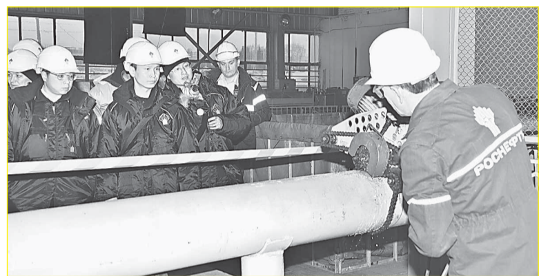
Установка безогневой врезки — «изюминка» ООО «Нефтетрубопроводсервис».
